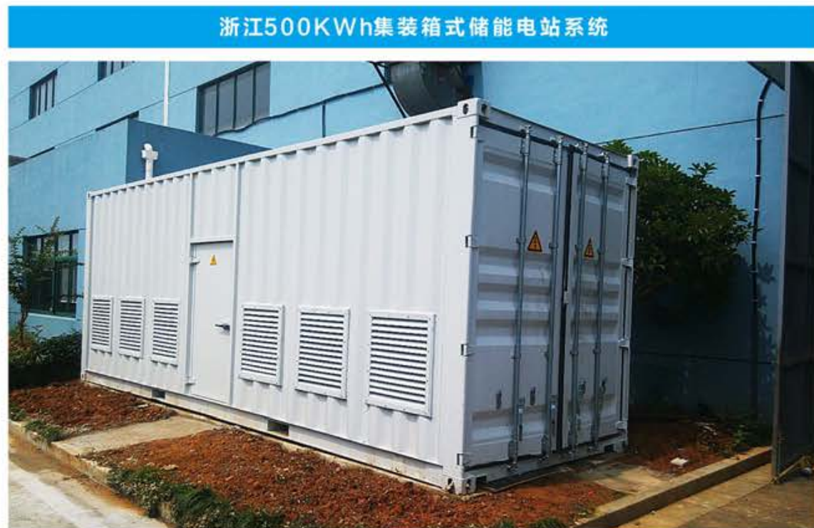
▲ 500KWh集装箱式储能电站照片
