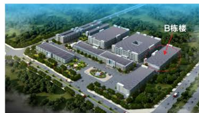
▲ 2MW微电网示范工程位置（B栋楼）
