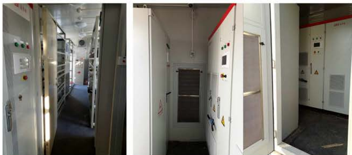
▲ 电池仓内部照（电池、空调等）
