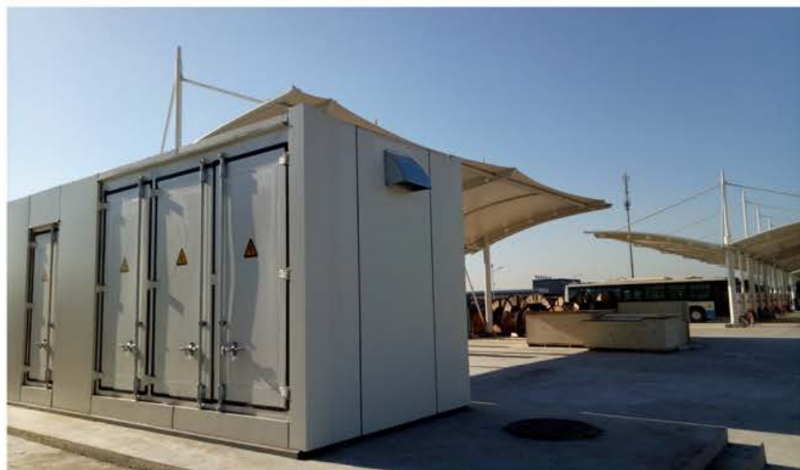
▲ 储能电站现场照片
